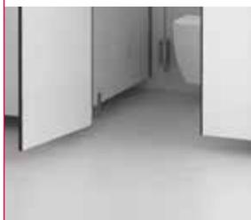
L'espace entre le sol et la façade avant et transversales est limité jusqu'à 15 ou 75mm.
